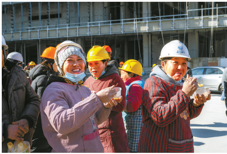
建筑工人品尝宁波传统美食。
