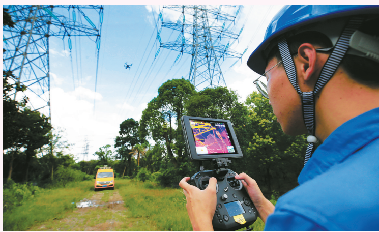
无人机在电力巡检中使用。
