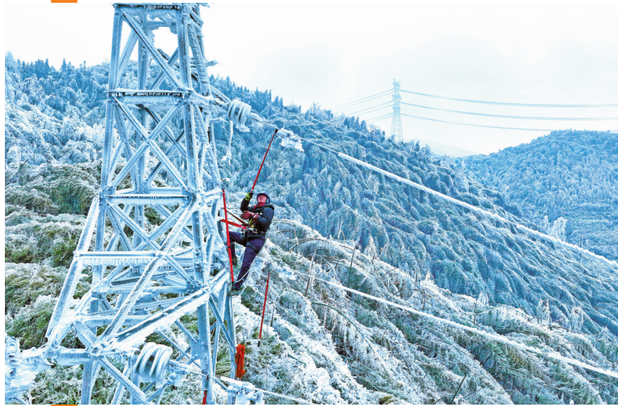
2024年2月25日，强寒潮影响我市，国网宁波供电公司工作人员对大明山区覆冰严重的线路进行修复。（王幕宾 王鹏 摄）
