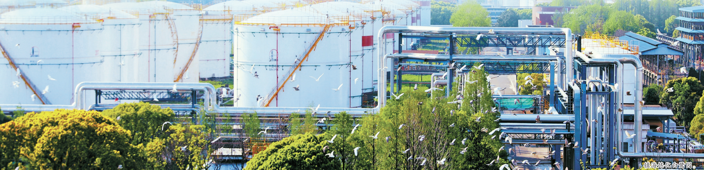
镇海炼化白贮罐。
