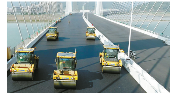
六横公路大桥梅山水道桥沥青摊铺。
