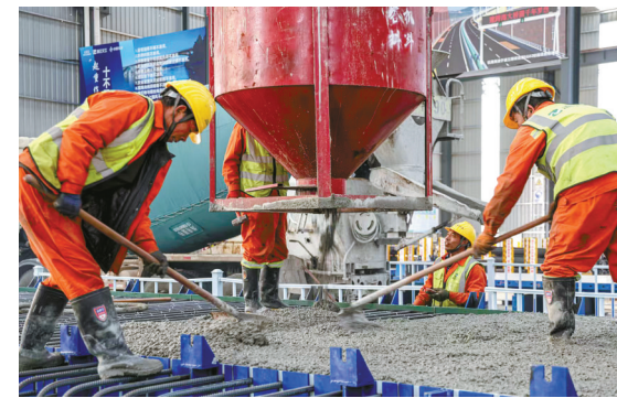
杭甬高速复线宁波段三期项目建设现场。
