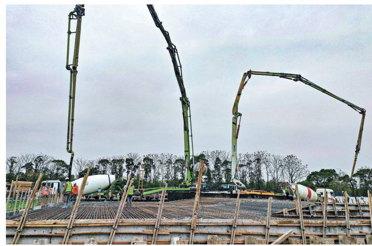
施工现场,泵车正在打混凝土。(王嘉彬 郁景雯 摄)
