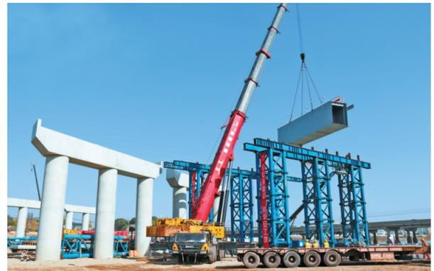
甬台温改扩建宁波南段段免溪2号桥首段钢箱梁吊装现场。（通讯员供图）
