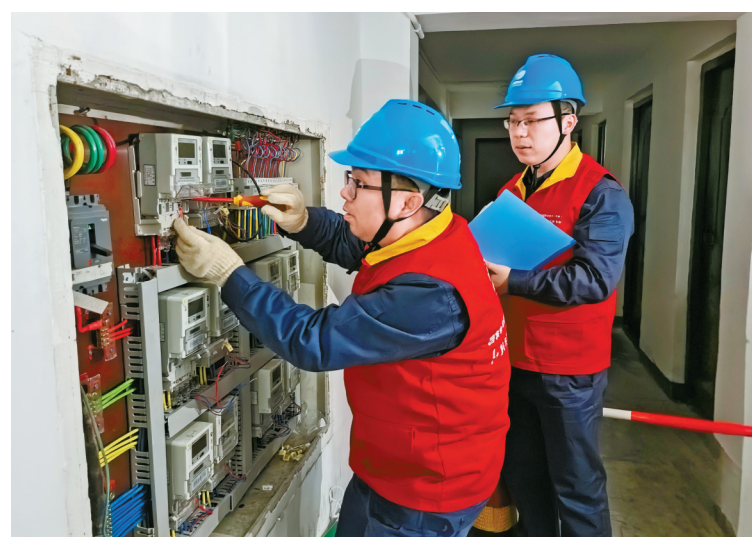
工作人员安装“不停电换表”装置。（赵煜 朱珊珊 摄）
