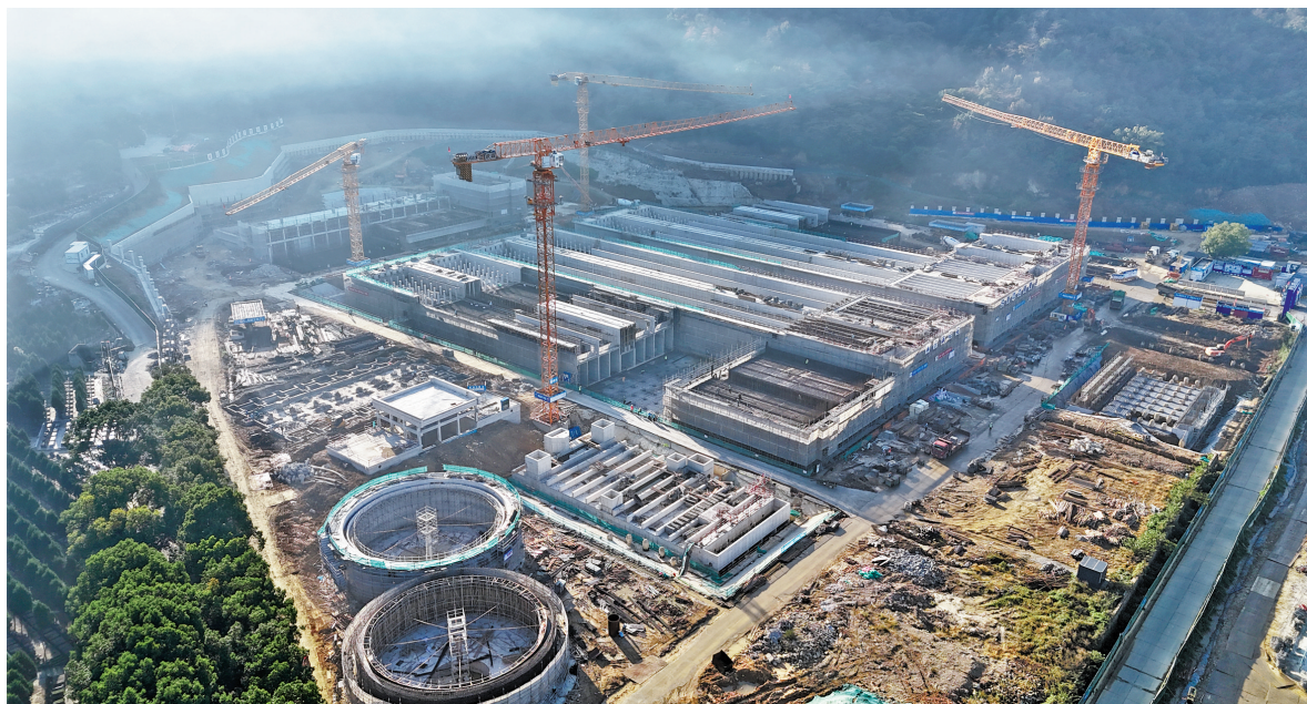
晨雾缭绕中的宁波第二工业水厂项目。
