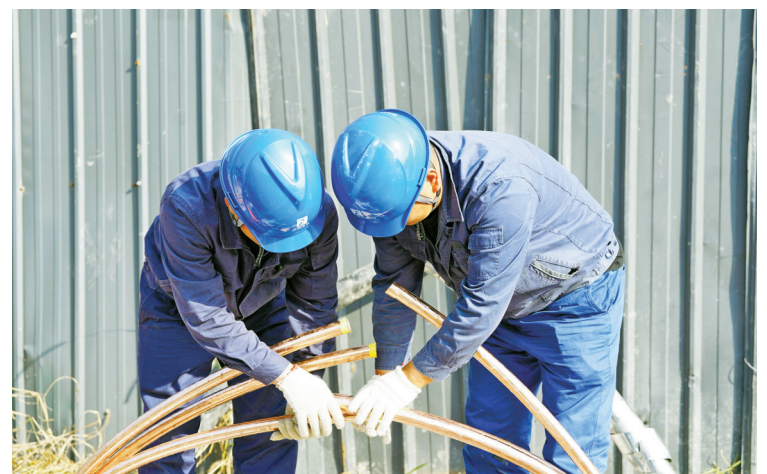
施工人员作业中。
