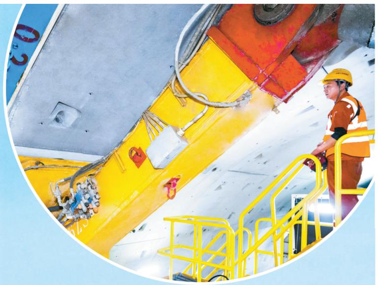
在“甬舟号”盾构机内部，建设者通过遥控器对管片拼装进行毫米级控制，再通过盾构机所搭载的同步双液浆工艺，使其快速达到有效强度，补偿地层损失，控制管片上浮。在目前掘进的1000多米距离中，地表沉降始终控制在5毫米以内，实现对地面既有建筑的零扰动。（沈莉 宋新宇 摄）
