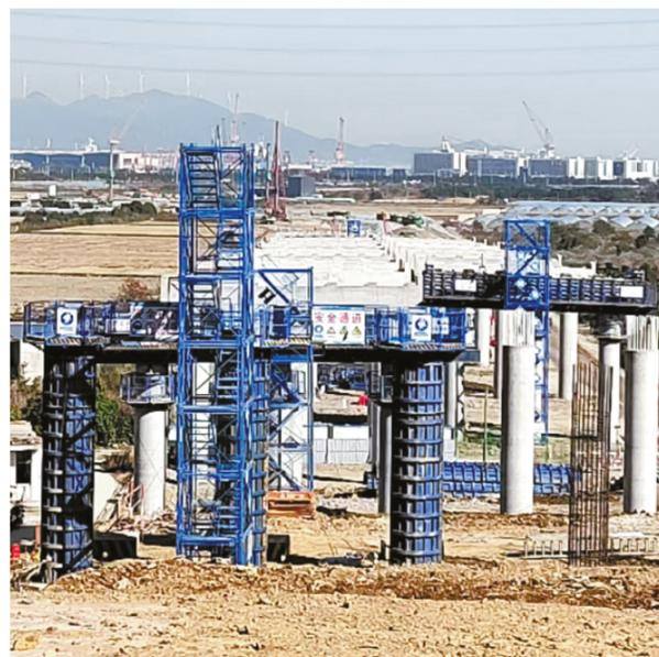
近日，甬舟高速复线东岙大桥最后一根桩基浇筑完成。自今年5月13日首根桩基开孔施工以来，经过200天连续奋战，东岙大桥114根桩基全部顺利浇筑完成，标志着东岙大桥施工由地下全面转到地上。
