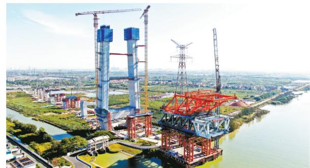
11月30日，由中铁大桥局承建的深江高铁洪奇沥水道公铁大桥首节段钢梁架设顺利完成，主桥上部结构正式进入钢梁拼装阶段。这也是深江高铁全线架设的首节段钢梁。据悉，深江高铁建成后，深圳与江门可实现1小时内通达，深圳与广州南沙自贸片区可实现半小时高铁互联互通。
