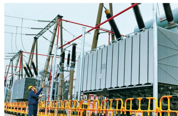
近日，宁波220千伏贤江变电站惰性气体泡沫灭火系统(IGFS)顺利投运，这是全省首套通过自动控制系统，实现泡沫、水及惰性气体混合液灭火的系统。据悉，传统变电站的灭火系统普遍存在灭火效能较弱和维护更换成本高的问题，而且有时还会发生误喷，容易造成主变设备跳闸停运。技术人员通过自主研发设计的比例混合器和气液混合器，将一定比例的惰性气体引入泡沫混合
