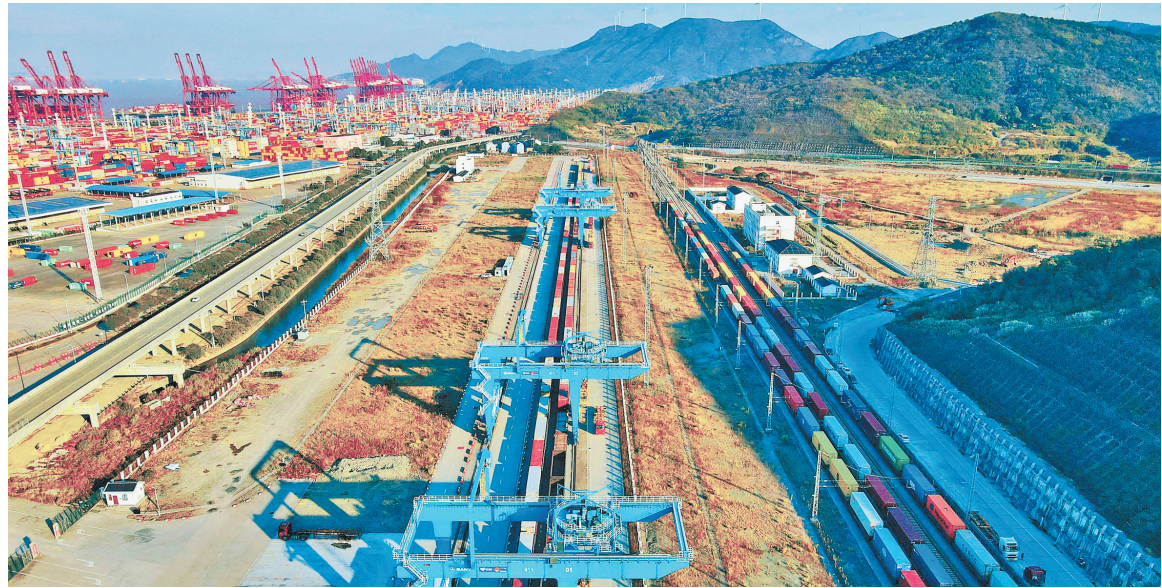
宁波舟山港海铁联运穿山港站作业现场。(吴梦凯 摄)
