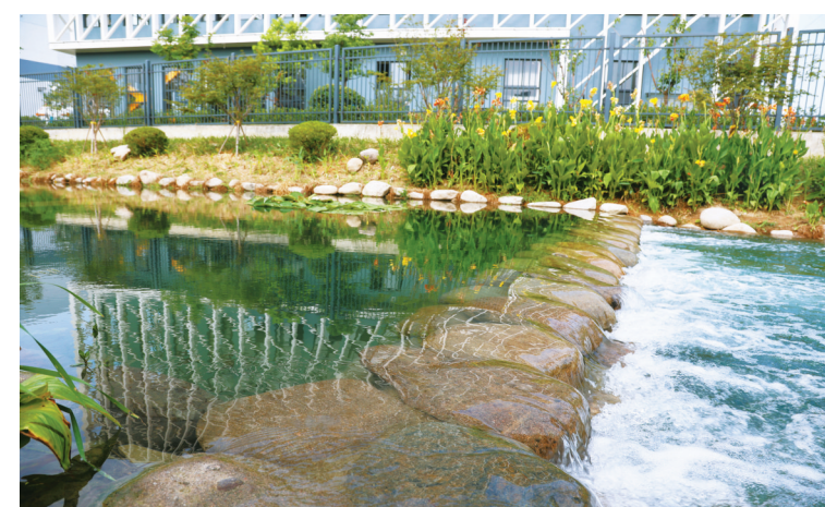
长丰净化水厂再生水回灌博家牵河。（市水务环境集团供图）
