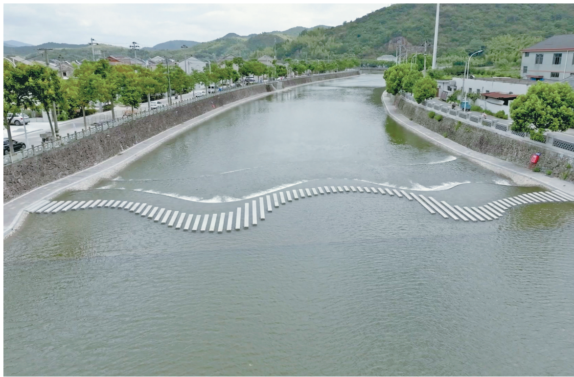
梅溪小流域综合治理工程正在推进。
