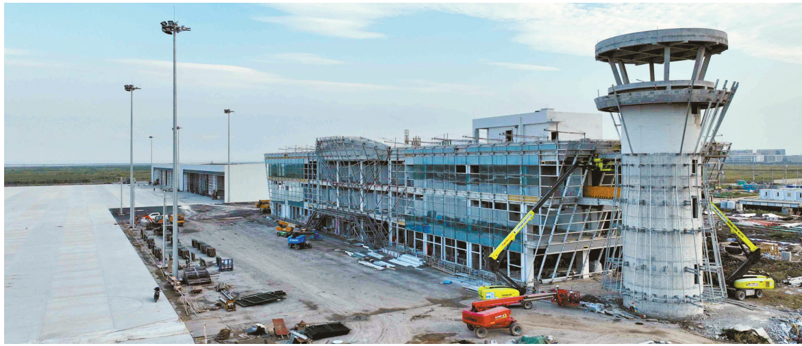
昨日，百余名工人奋战在宁波前湾新区通用航空机场，目前，该机场飞行区场道工程主体施工已完成，正在进行各类线缆敷设与附属设施施工，据悉，该机场一期项目争取在今年底完成建设。（徐能 虞昌胜 摄）
