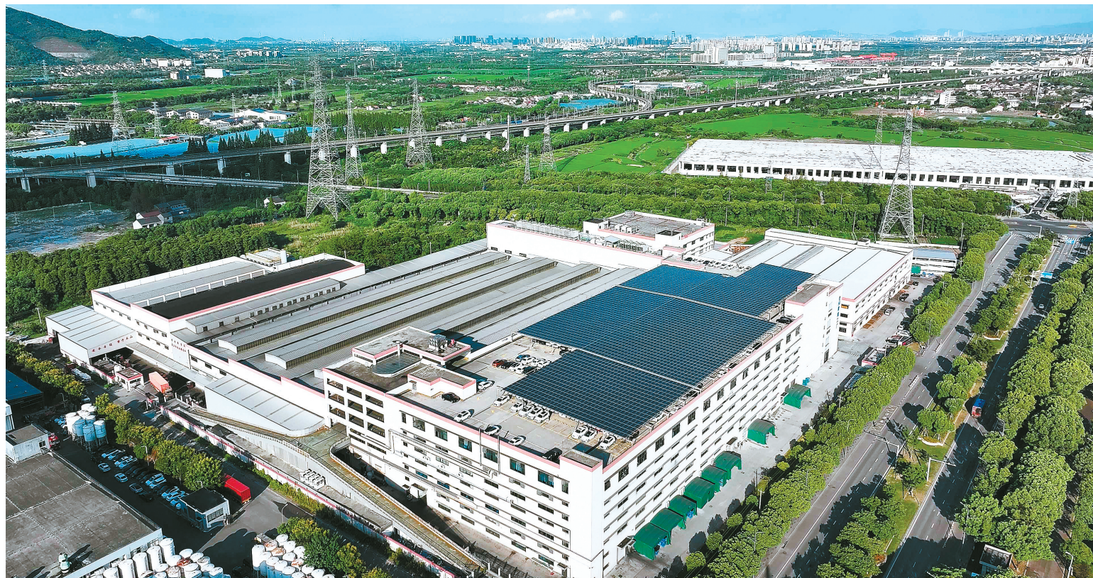
爱柯迪股份有限公司3号工厂的屋顶光伏车棚。
