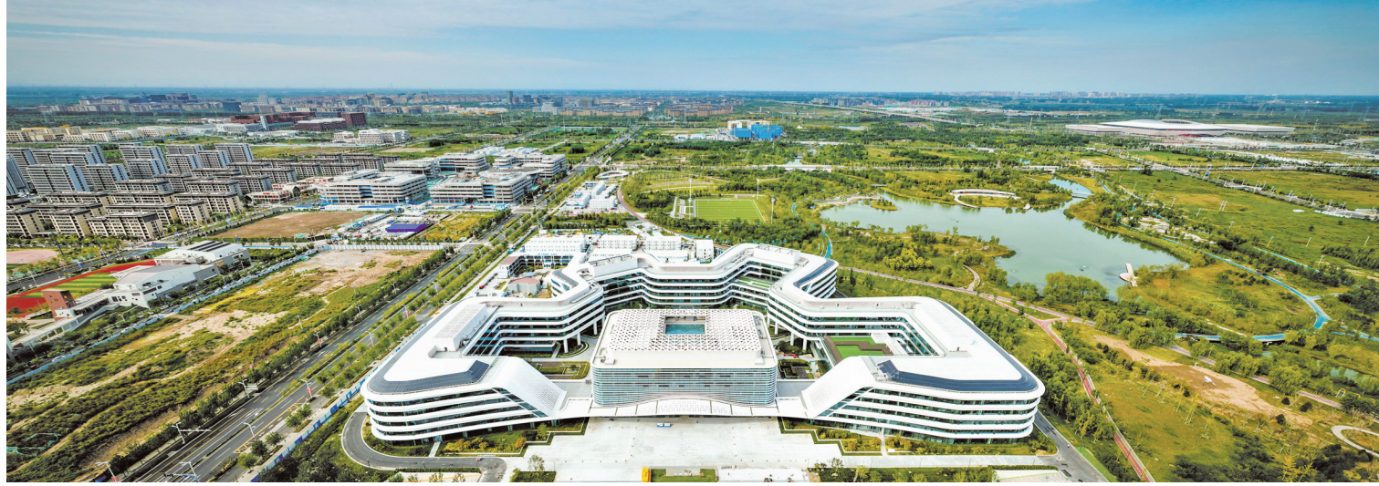
近日，雄安新区首家落户央企中国星网总部竣工交付。图为雄安总部办公楼（9月13日摄，无人机照片）。
