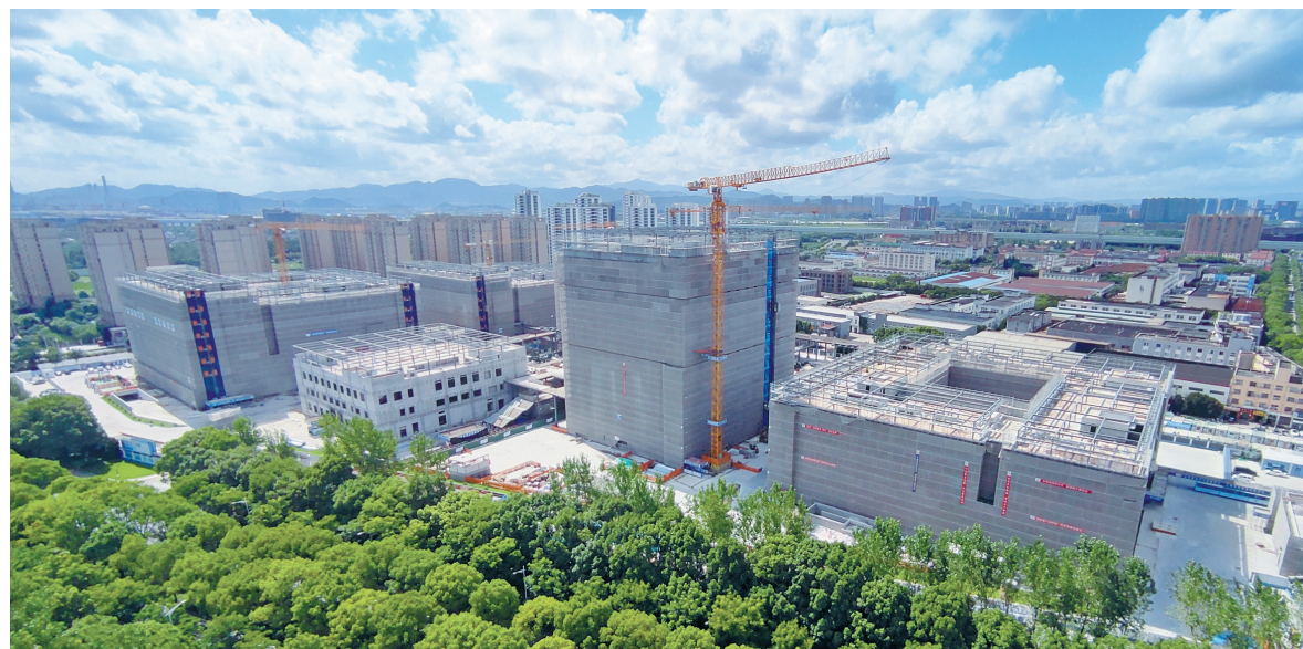
甬江实验室知园建设现场。(甬江实验室供图)
