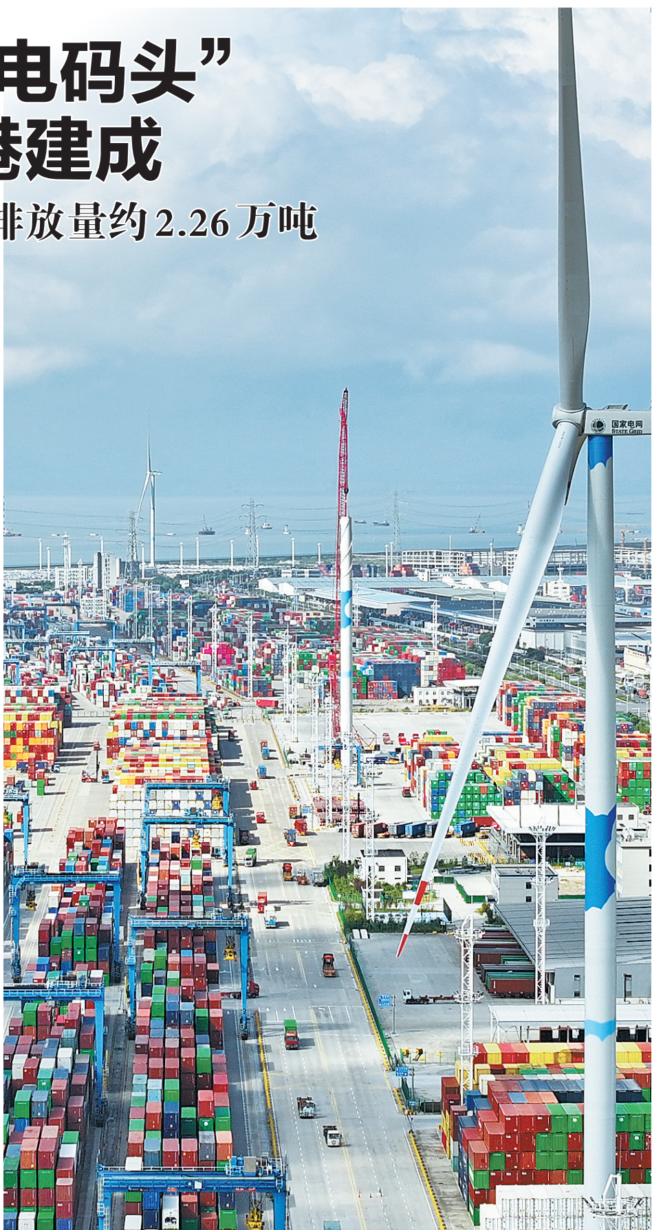
浙江省首个低碳码头示范工程——国家电网宁波舟山港风光储一体化项目顺利投运。（张晋豪 摄）
