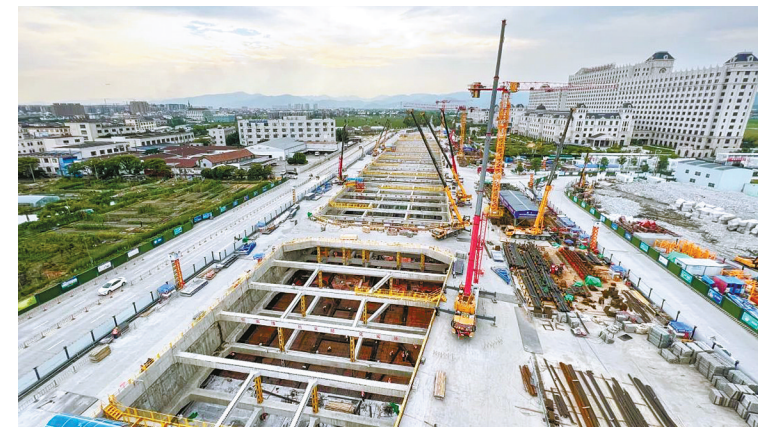
汇士路站建设中。
