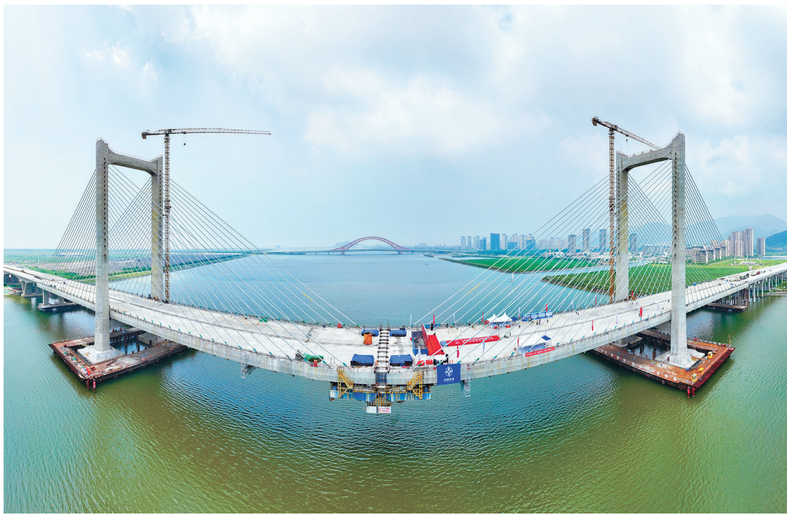
梅山水道桥顺利合龙。
