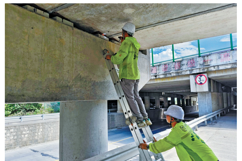
工作人员对桥涵进行检测。（金鹭 肖慧双 摄）
