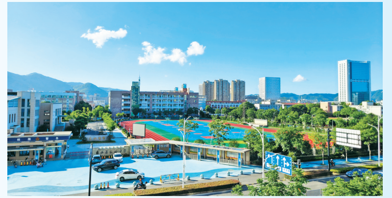
象山县实验中学操场未见施工迹象。
