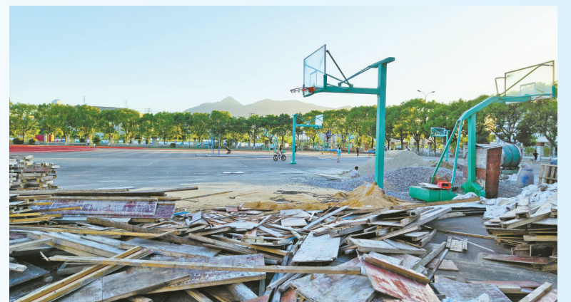
象山县实验小学施工、开放两不误。
