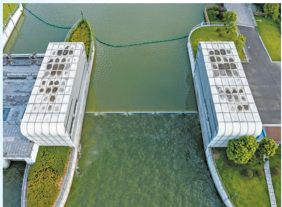
五江口闸站翻板闸门正在运行。
