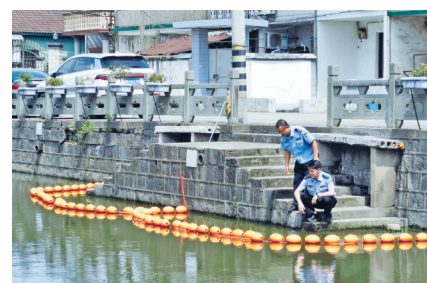
鄞州姜山镇联荣村安装的新型河埠头防护网。(王晓峰 摄)
