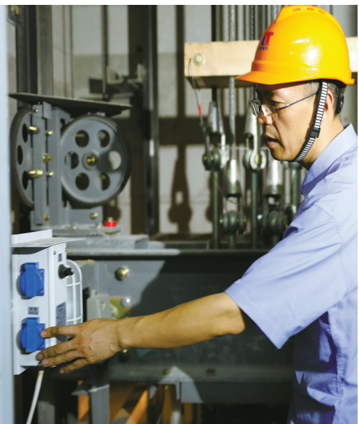
检验人员正在对电梯进行检验。(王嘉彬 摄)
