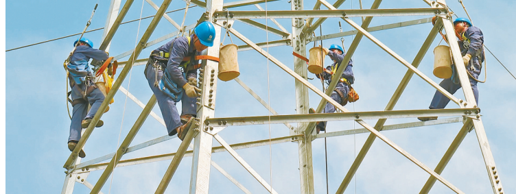
电力工人“挂”在铁塔上作业。
