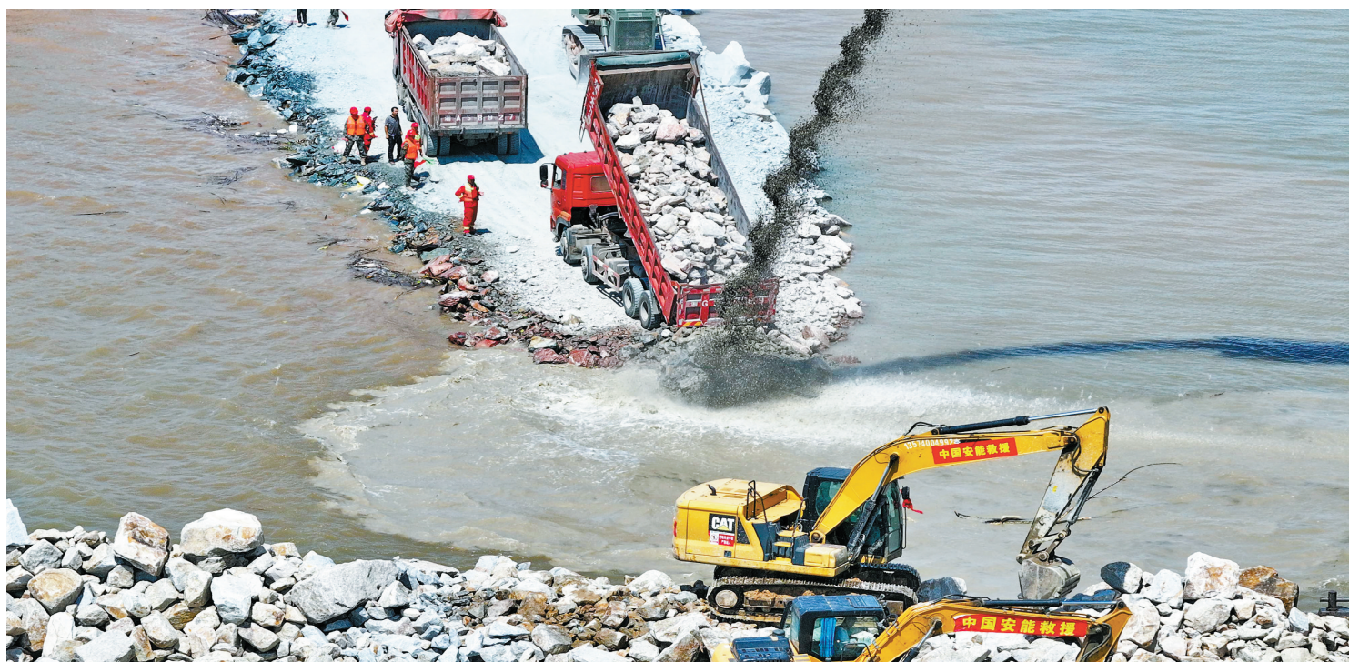
七月八日，在湖南省岳阳市华容县团洲垸洞庭湖大堤决口现场，抢险队伍正在紧张进行堵口作业。新华社记者陈振海摄。
