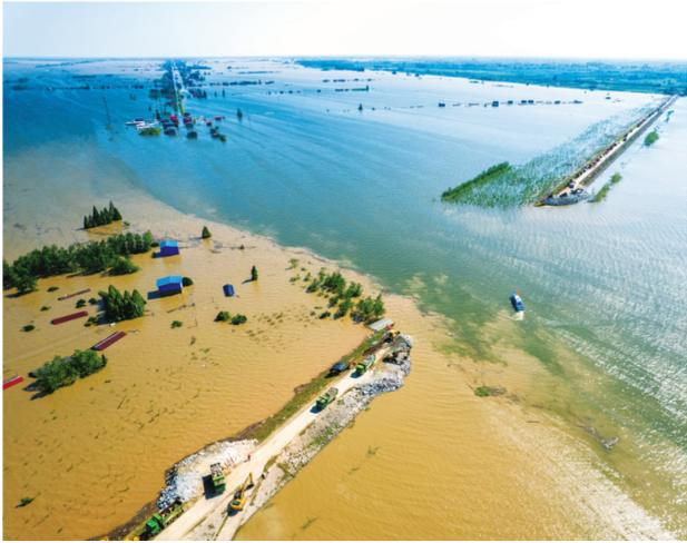
7月6日，抢险队伍在进行堵口作业（无人机照片）。
