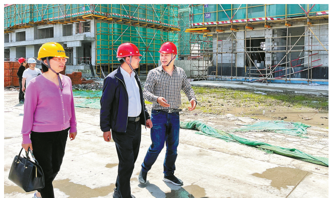
余姚市纪委监委派驻第八纪检监察组深入兰江街道谭家岭西路堰头地块居住用房项目施工现场开展监督。(赵红钢 摄)
