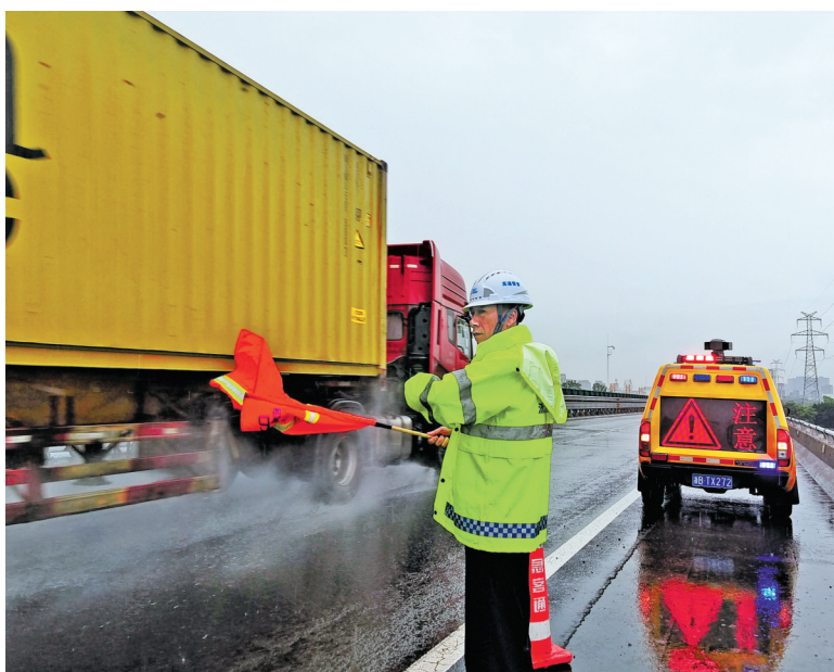
高速公路工作人员在工作中。
