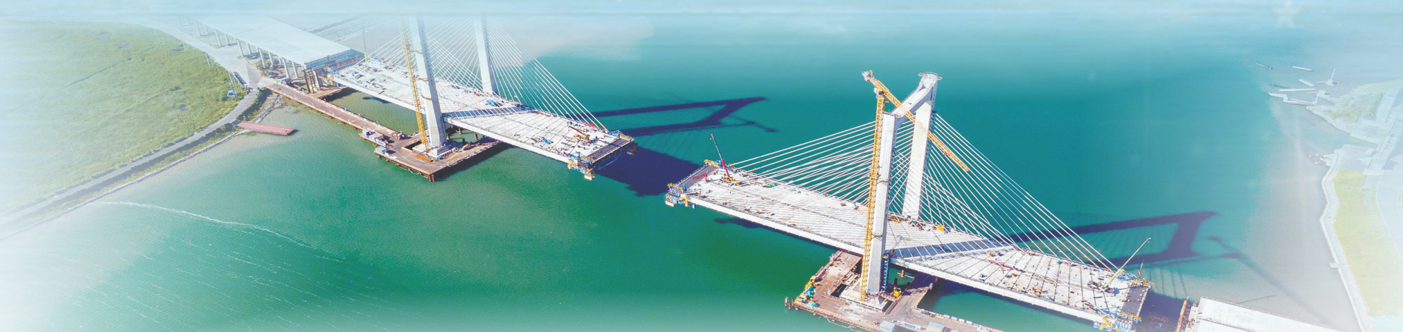
建设中的六横公路大桥。
