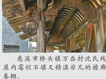
慈溪市桥头镇万岙村沈氏残屋内霉烂不堪又精湛非凡的檐廊卷棚。
