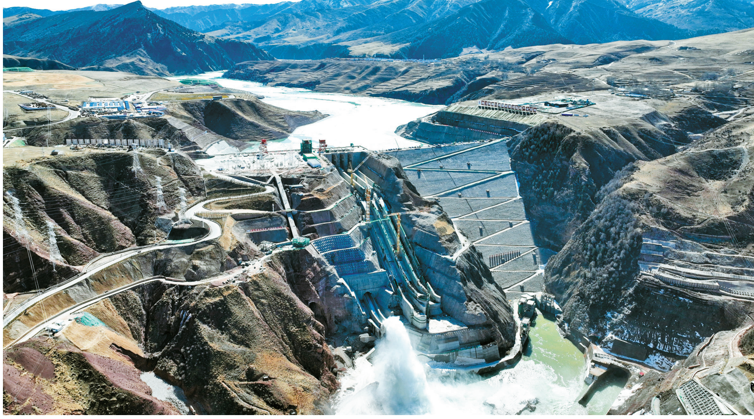
这是4月1日拍摄的玛尔挡水电站(无人机照片)。4月1日,玛尔挡水电站首台5号机组正式并网发电。该水电站位于青海省海南藏族自治州同德县与果洛州玛沁县交界处的黄河干流上,项目所在地平均海拔3300米,总装机容量232万千瓦,是黄河流域在建海拔最高、装机最大的水电工程,属于国家和青海省重点能源项目,也是国家实施“西电东送”和“青电入豫”的骨干电源点,电站预计2024年12月实现全部机组投产发电。(新华社发)
