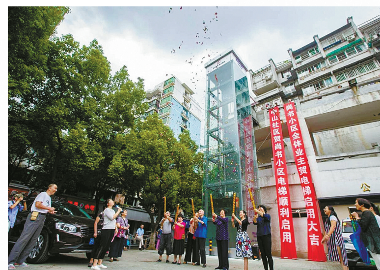
老旧小区加装电梯让人们生活更便利
