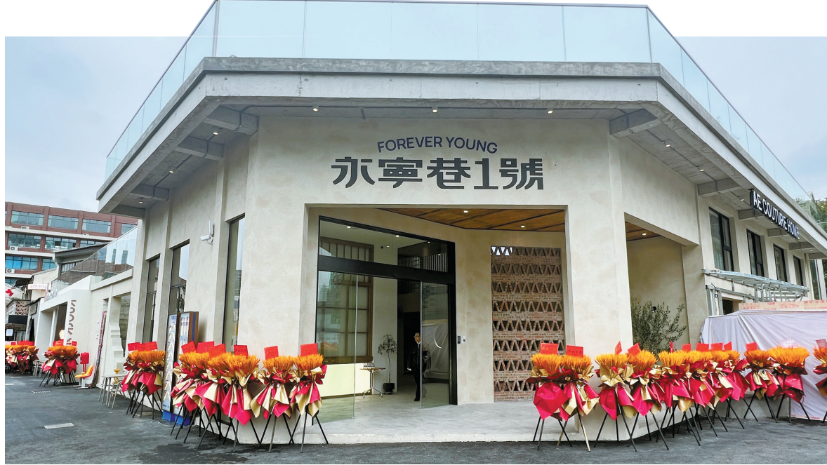
永宁巷1号商业街区入口。
