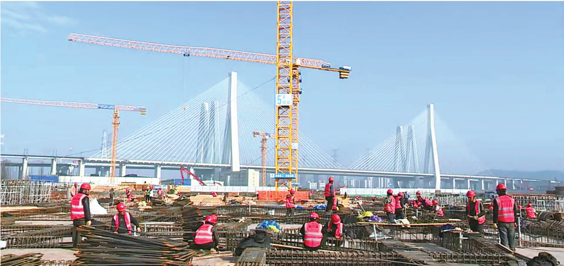
浙江二建宁波东方理工大学（暂名）永久校区东生活组团项目施工现场。（王马飞 摄）
