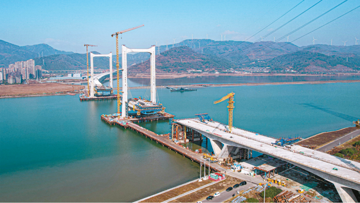
六横公路大桥一期。
