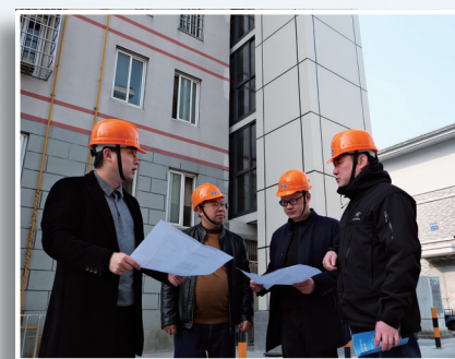
电梯加装现场
