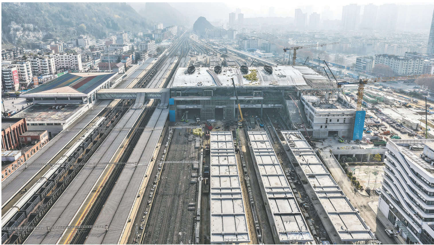
12月11日拍摄的六盘水站站房及站场改造工程施工现场(无人机照片)。安顺至六盘水高速铁路六盘水站站房及站场改造工程在稳步推进中。日前,由中铁电气化局承建的六盘水站站房钢网架提升工程顺利完成,站房内部施工及相关配套设施正在建设中。 新华社发
