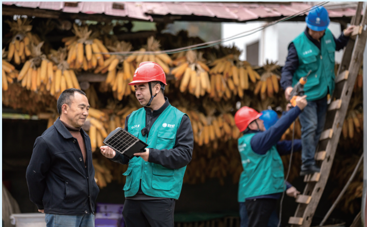
2024年11月,到四川凉山州甘洛县安装光伏路灯。
