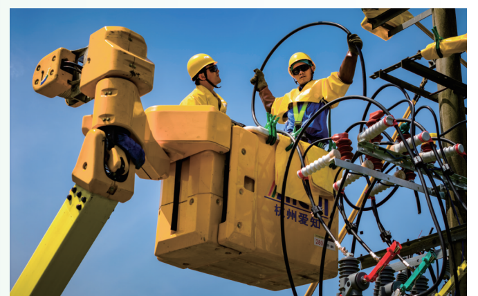
区供电公司员工在裘村镇闫家村开展带电作业
