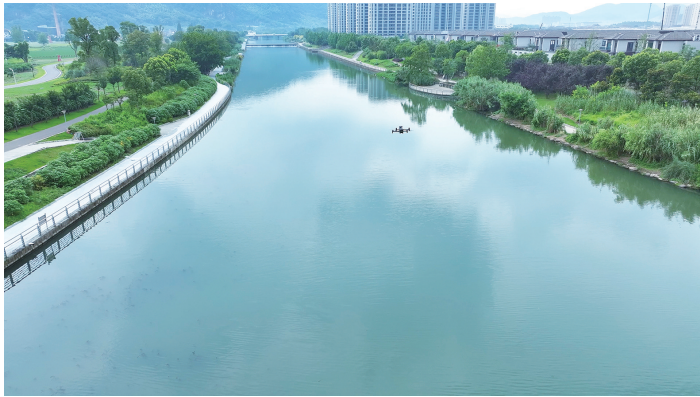
◀无人机正在 巡查河面情况
