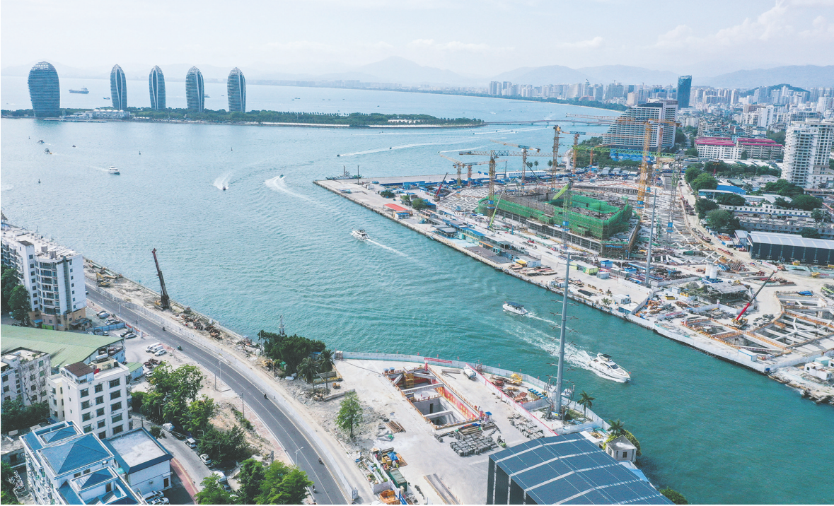
这是5月5日拍摄的三亚河口通道工程项目现场（无人机照片）。
