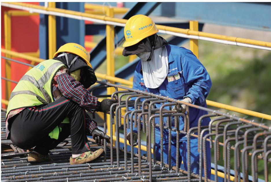
7月9日,施工人员在中铁大桥局杭州湾梁场绑扎钢筋。
