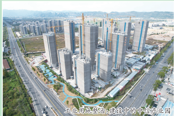
工业用地整治,建设中的中信产业园
