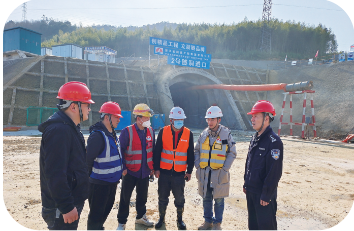
治安大队民警检查爆破现场,指导安全生产工作
