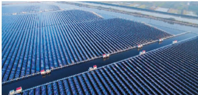
昨天,在慈溪周巷水库和长河水库水面上,全国最大“渔光互补”光伏发电项目投运。该项目总投资18亿元,总水域面积4492亩,总装机容量达200兆瓦,预计年均发电量约2.2亿千瓦时,可以满足10万户家庭一年的用电量,相当于节约标准煤7.04万吨。
